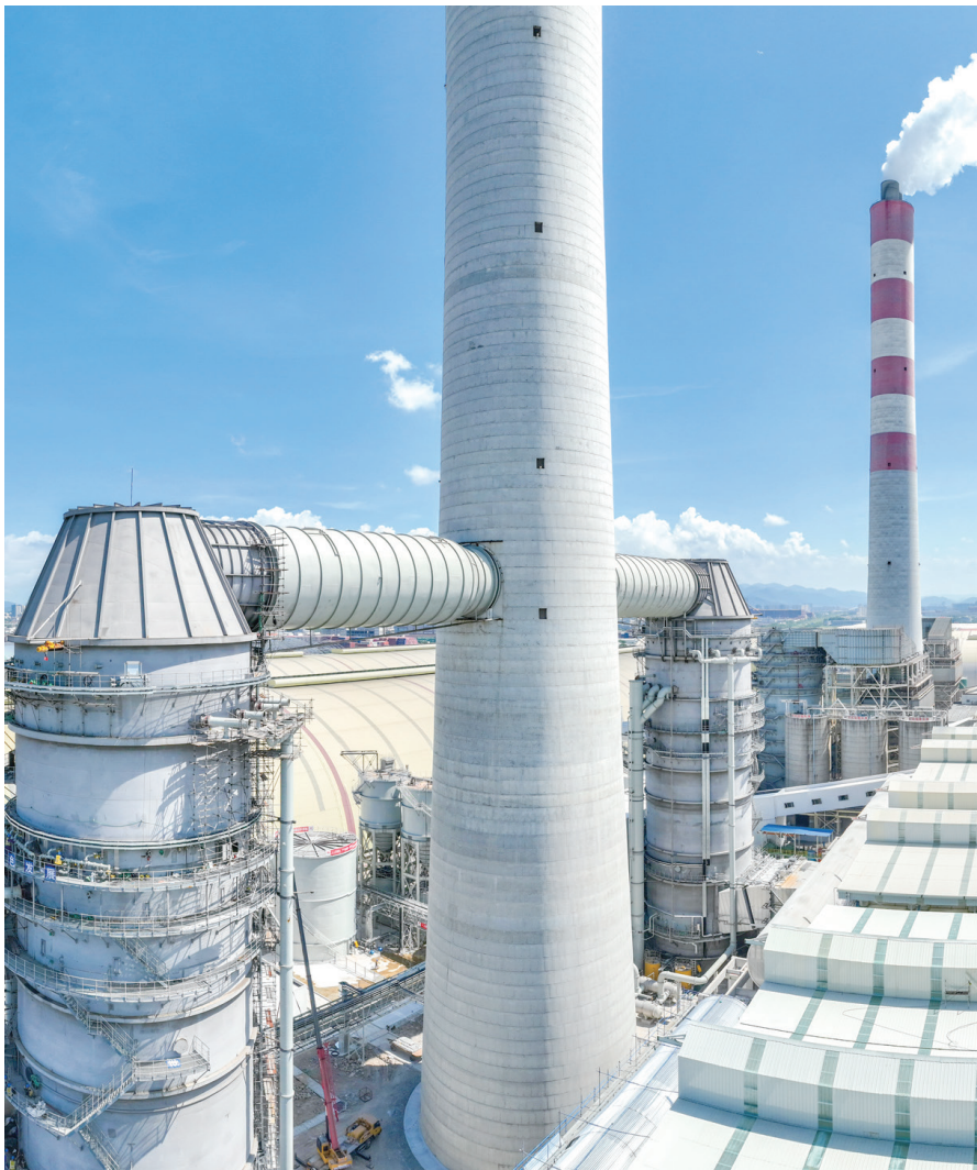
图 1 北仑电厂完成国内首台 1000 兆瓦超超临界二次再热机组高效脱硫除尘一体化技术示范应用
